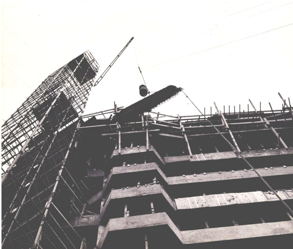
作業がタワーの上層階に移るにつれ、ホイストタワーブームが拡張されたスチールメッシュ補強材の束を持ち上げます
